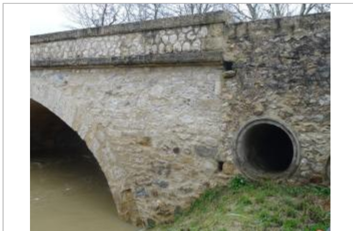
Pont de la RD83 sur le Lens
