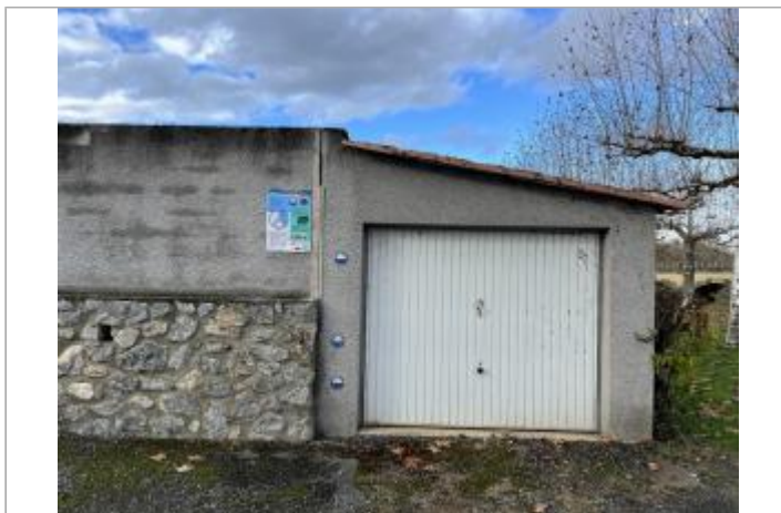
Garage à l'angle Sud-Est du cimetière
