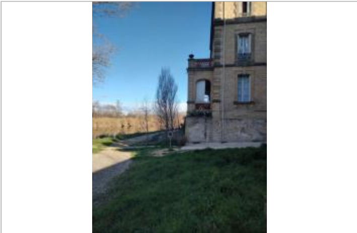
Façade de la dernière maison rue Cournilhe - côté Gardon
