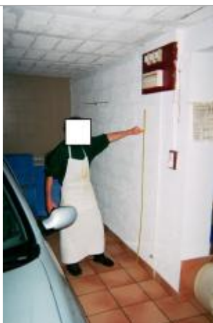
sous-sol de la maison au 1 rue du Blavet
