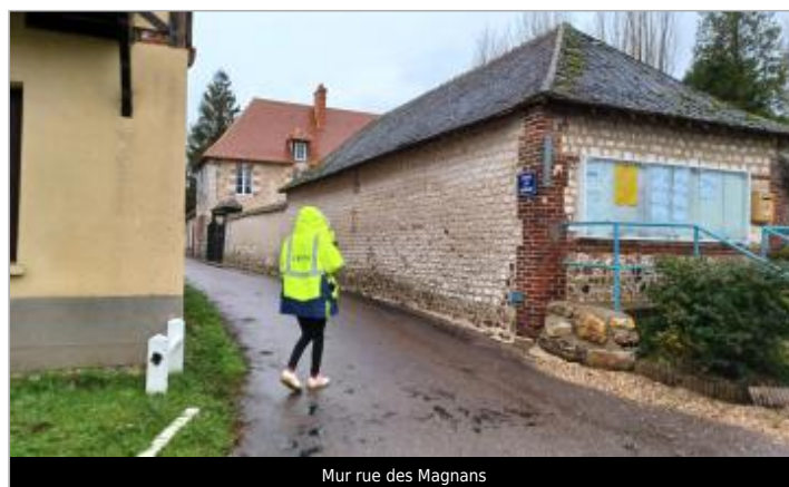
Mur rue des Magnans
