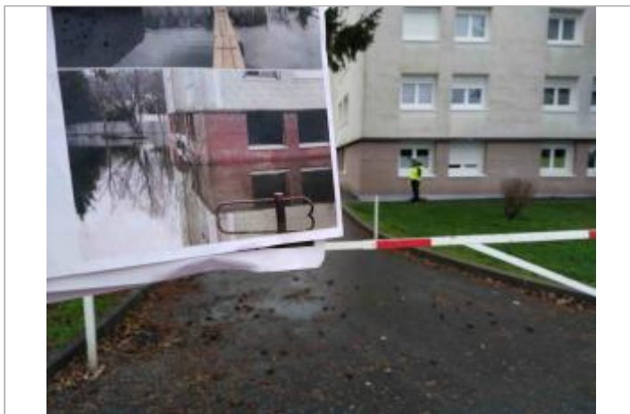
Façade de l'immeuble.
