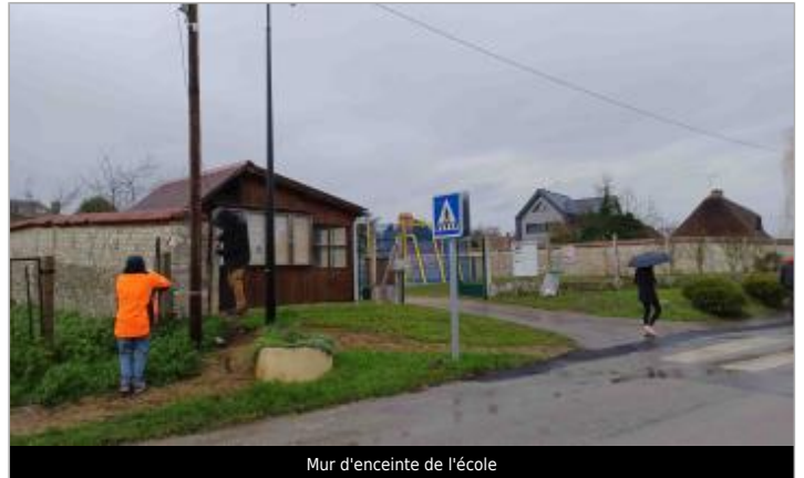
Mur d'enceinte de l'école
