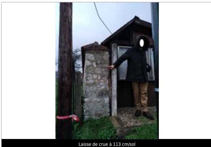
Laisse de crue à 113 cm/sol
