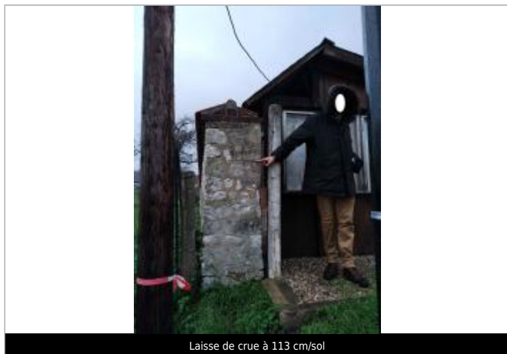
Laisse de crue à 113 cm/sol
