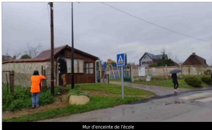
Mur d'enceinte de l'école
