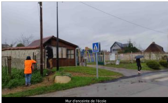
Mur d'enceinte de l'école
