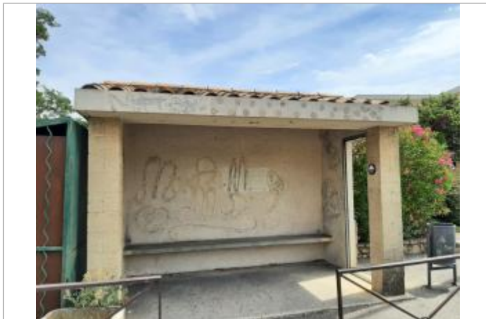
pilier de l'arrêt de bus
