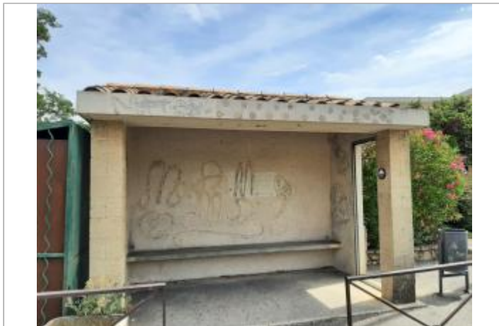
pilier de l'arrêt de bus
