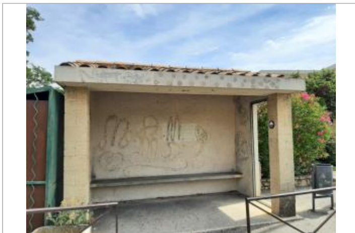
pilier de l'arrêt de bus
