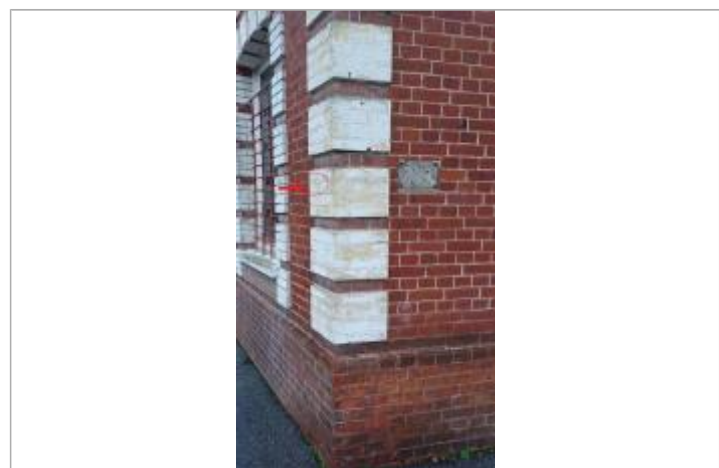
Trace gravée "1966" à 165 cm/sol.
