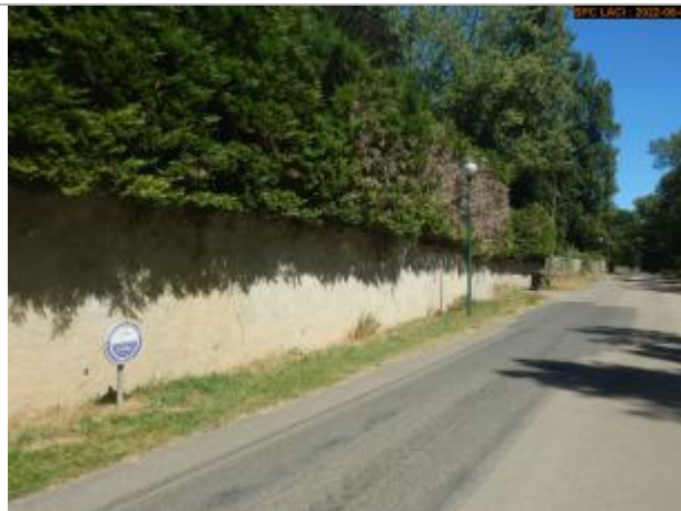
Vue du site éloignée
