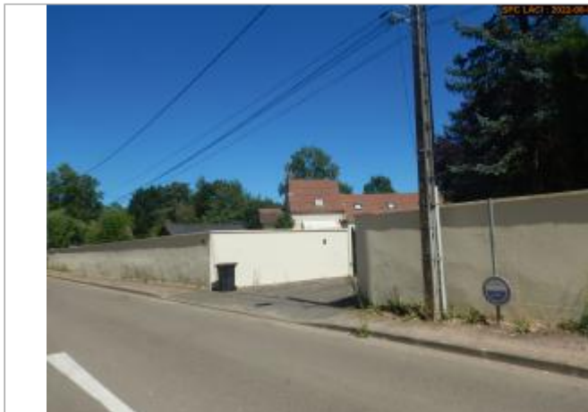
Vue du site éloignée
