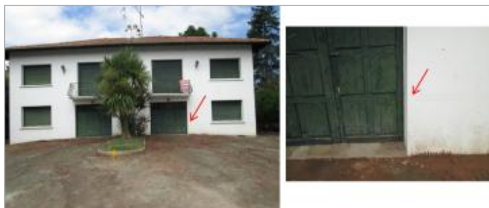
Vue de la laisse - auteur : HYDRATEC
