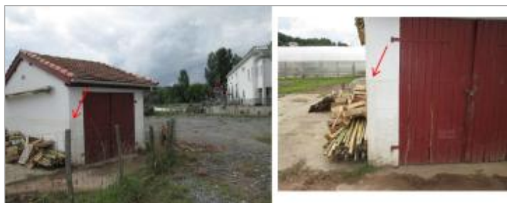
Vue de la laisse - auteur : HYDRATEC
