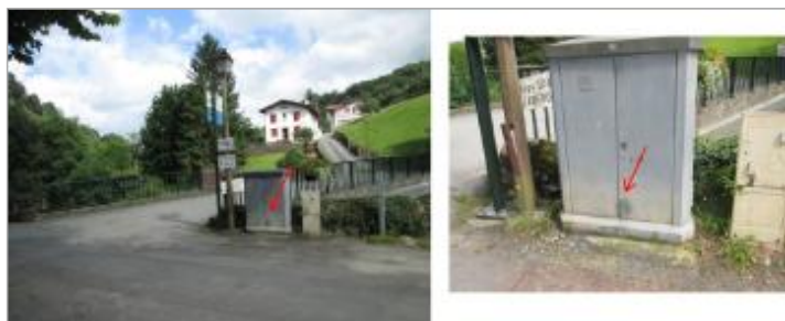
Vue de la laisse - auteur : HYDRATEC
