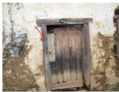
Vue de la laisse - auteur : HYDRATEC
