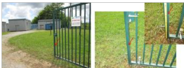
Vue de la laisse - auteur : HYDRATEC
