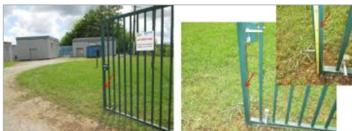
Vue de la laisse - auteur : HYDRATEC
