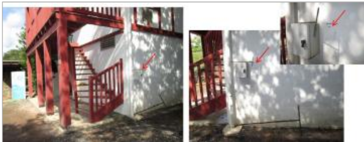
Vue de la laisse - auteur : HYDRATEC
