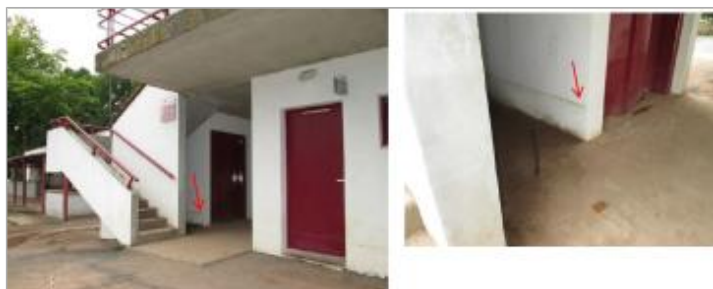
Vue de la laisse - auteur : HYDRATEC
