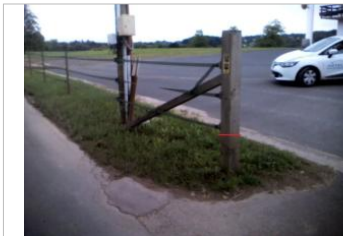
Vue de la laisse - auteur : ARTELIA
