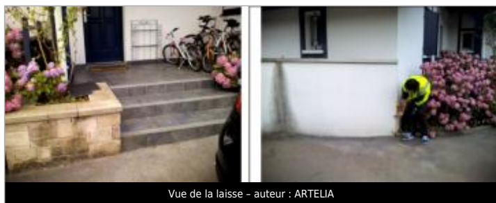
Vue de la laisse - auteur : ARTELIA
