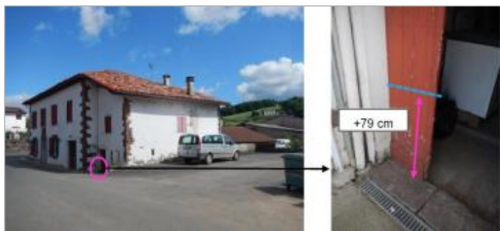
Vue de la laisse - auteur : ISL
