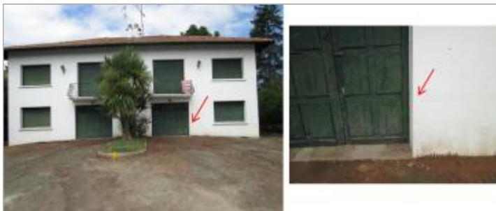
Vue de la laisse - auteur : HYDRATEC
