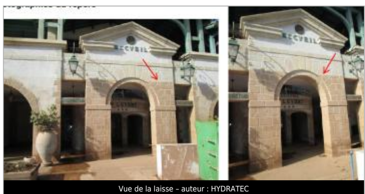
Vue de la laisse - auteur : HYDRATEC
