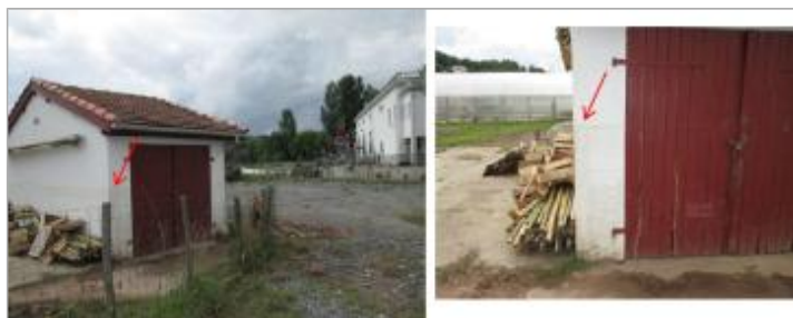
Vue de la laisse - auteur : HYDRATEC
