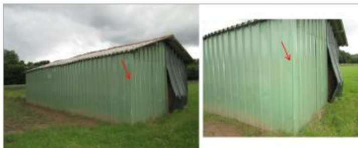
Vue de la laisse - auteur : HYDRATEC
