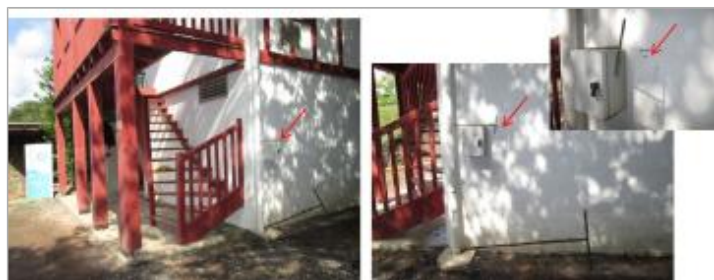
Vue de la laisse - auteur : HYDRATEC
