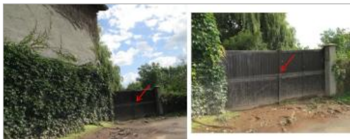
Vue de la laisse - auteur : HYDRATEC
