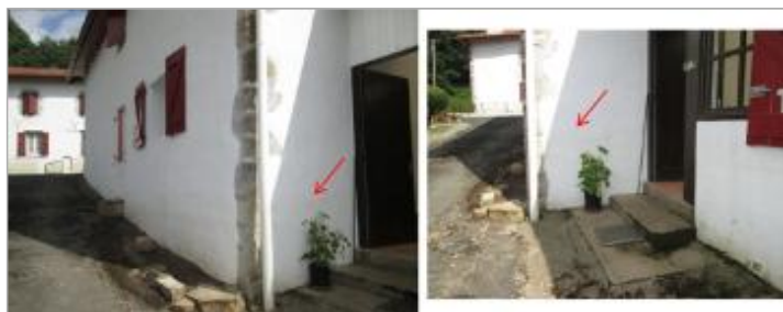
Vue de la laisse - auteur : HYDRATEC
