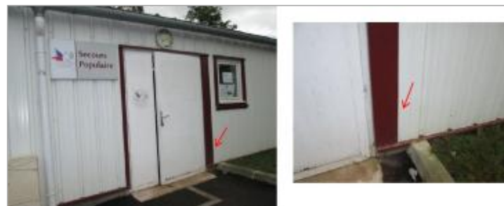
Vue de la laisse - auteur : HYDRATEC
