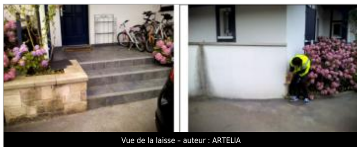
Vue de la laisse - auteur : ARTELIA
