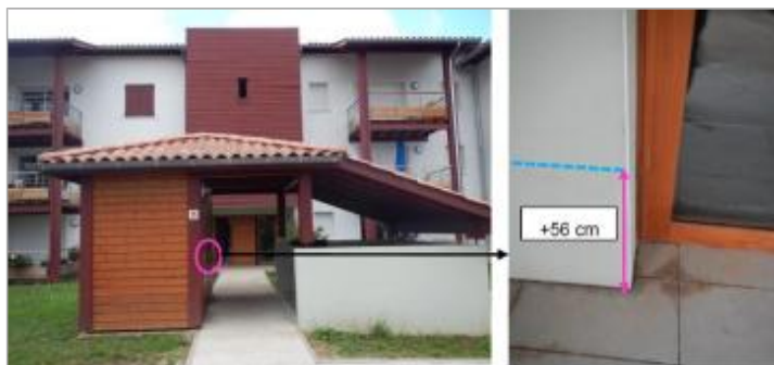
Vue de la laisse - auteur : ISL
