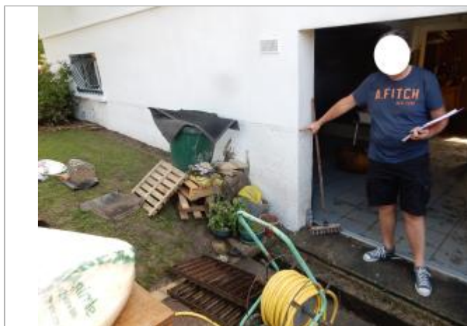
Laisse de crue à 114 cm/sol
