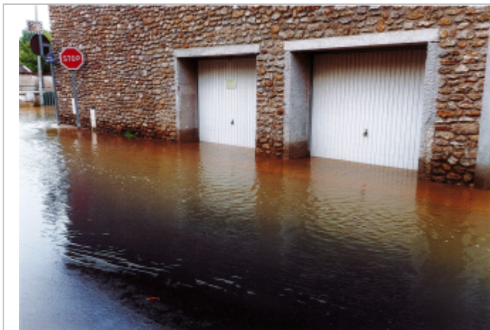
mesure sur le mur en meulière
