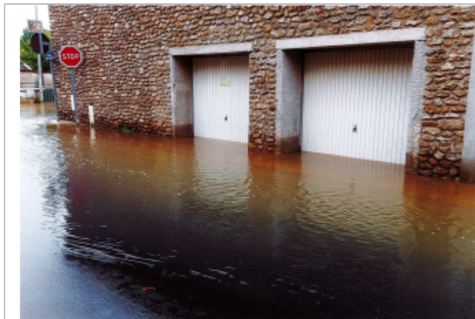
mesure sur le mur en meulière
