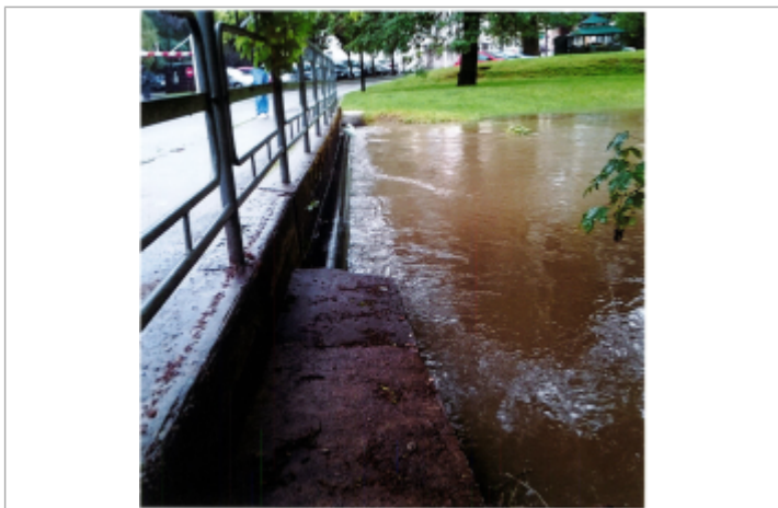
pont entre la rue du Moulin et la rue de la corderie, eau jusqu'au pont
