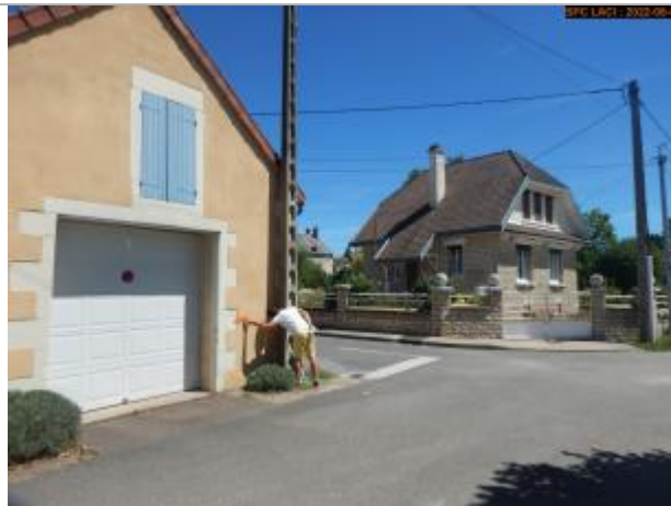
Vue du site éloignée (montant de la porte garage)
