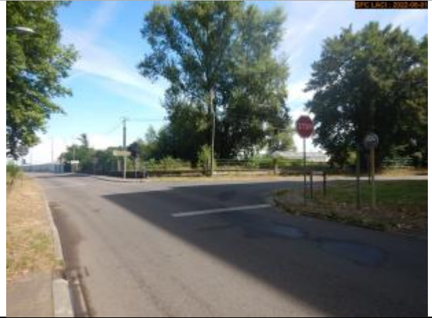
Vue du site éloignée
