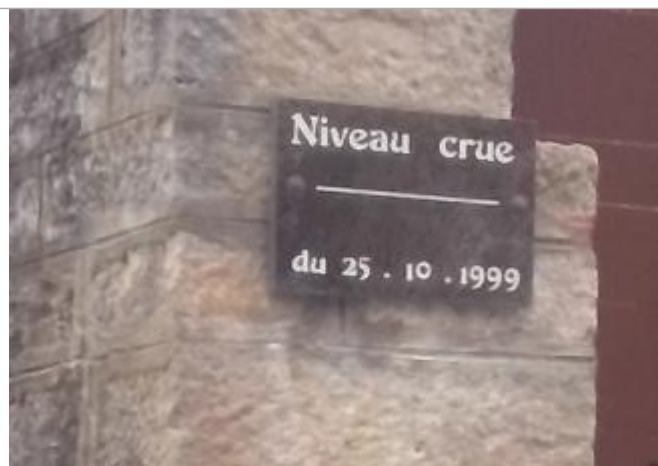
plaque à 1.35m du sol environ, au-dessus du point d'eau
