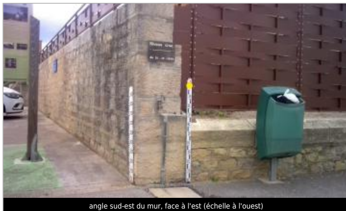
angle sud-est du mur, face à l'est (échelle à l'ouest)
