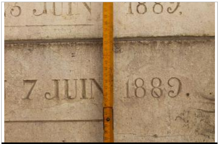
marque à 40cm du sol
