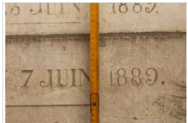
marque à 40cm du sol
