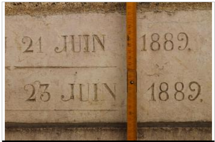
marque à 55cm du sol
