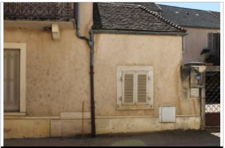
au pied de la façade sur la rue, à gauche de la descente de gouttière
