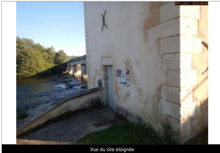
Vue du site éloignée
