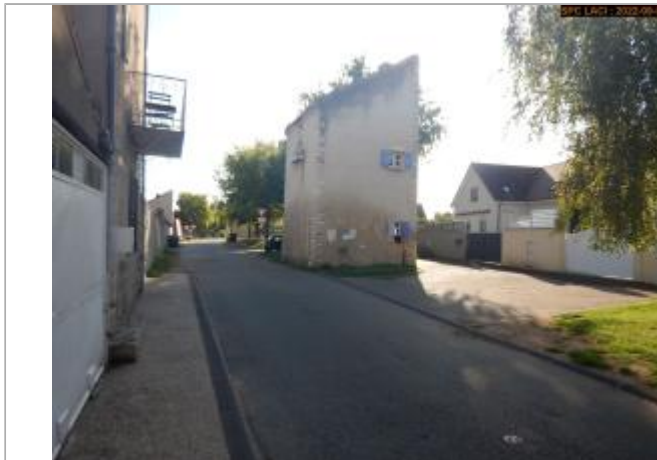
Vue du site éloignée
