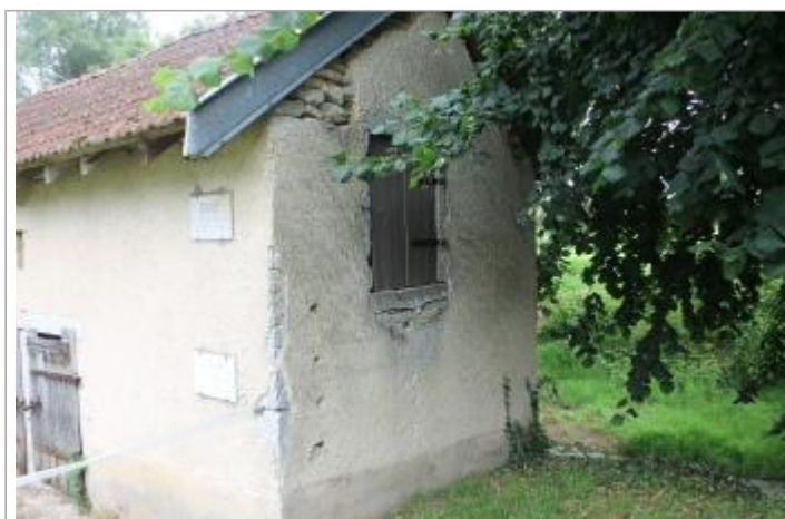
angle sud-ouest du bâtiment
