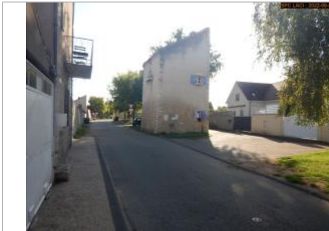
Vue du site éloignée
