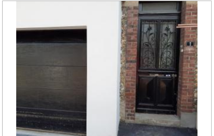
Porte de garage donnant sur la rue
