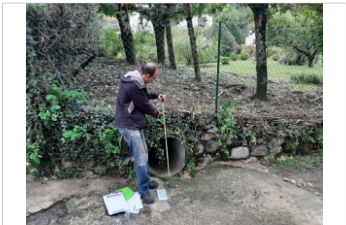
laisse de crue sur le grillage
