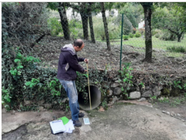
laisse de crue sur le grillage
