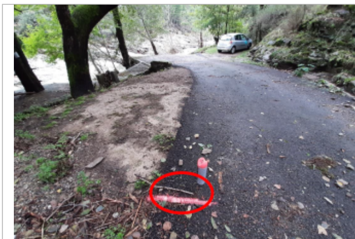
Limite d'inondation sur route de Chareneuve RG
